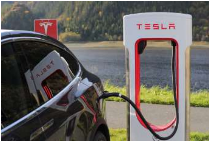
Tesla elbilar och laddningsutrustning
