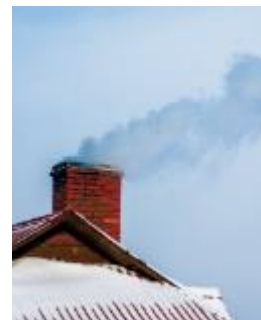
Bild 88. Miljökraven för emissioner från fastbränsleeldade pannor finns i BBR. Reglerna är på väga att skärpas och kommer att motsvara EN 303-5 klass 5 och sedan efter 2020 böttna i Ecodesignkraven.
