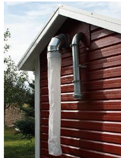
Bild 21. Exempel på avluftning med dammfilter t.v. Inblåsningsrör med handkoppling t.h.
