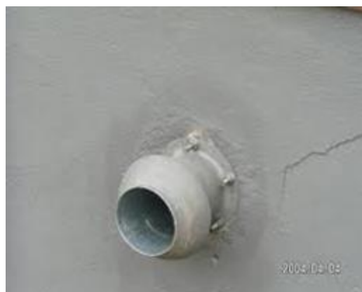
Bild 20. Inblåsningrör med sk hankoppling
