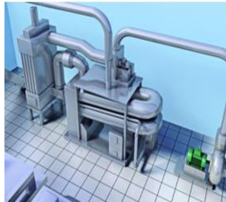
Bild 122. Rökgaskondensering är ett alternativ som även ökar verkningsgraden.
