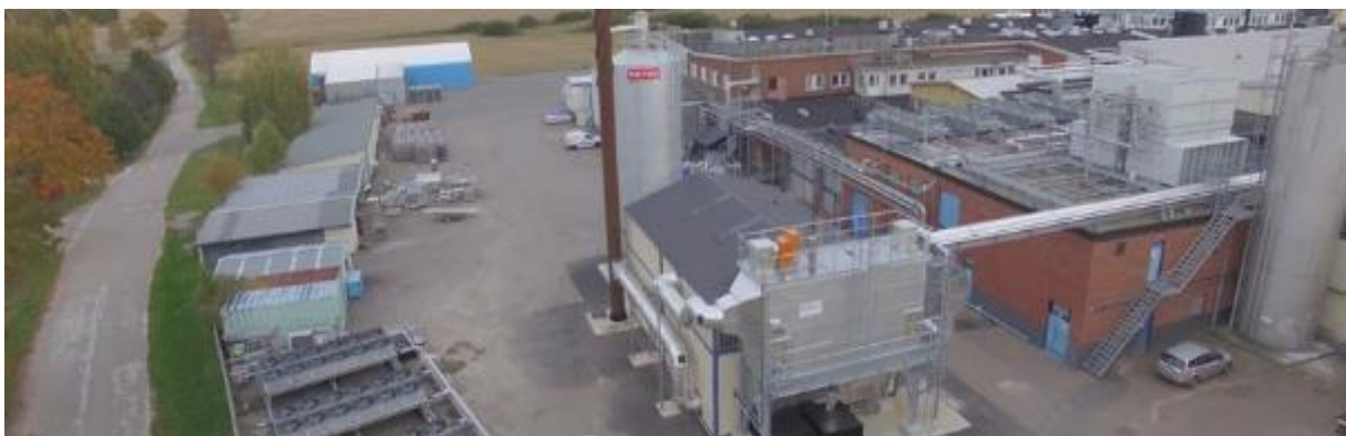
Bild 119. Bilden ovan är från Atria som är en stor tillverkare av livsmedel under varumärken som Sibylla, Lithells och Ridderheims. Under hösten 2015 tog Atria i drift en ny ångcentral som kan leverera 6 MW ånga med träpulver till fabriken i Sköllersta. Se filmen här ( http://www.petro.se/Om-Petro/Referenser/Ny-panncentral-hos-Atria )
