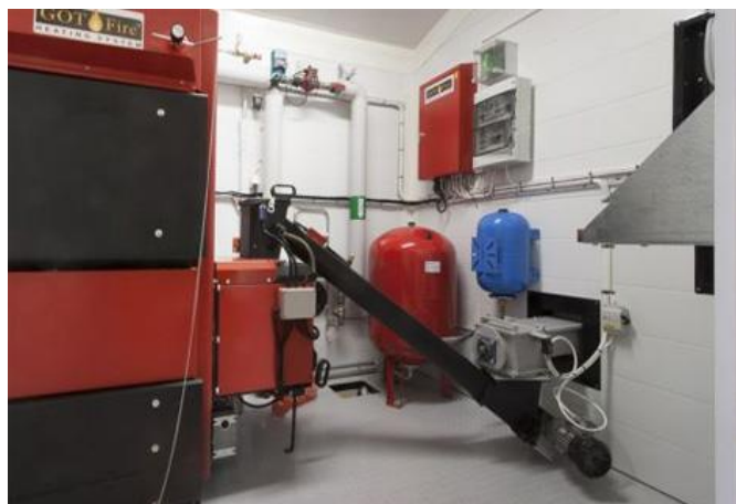
Bild 12. Bilden visar hur flisen skruvas från förrådet till pannan
