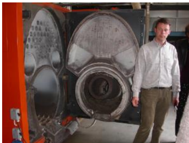
Bild 115. Pelletsbrännare inom när- och industrivärme liknar i mycket en "större villabrännare". Bilden ovan anläggning med en Janfire-brännare på 300 kW.
