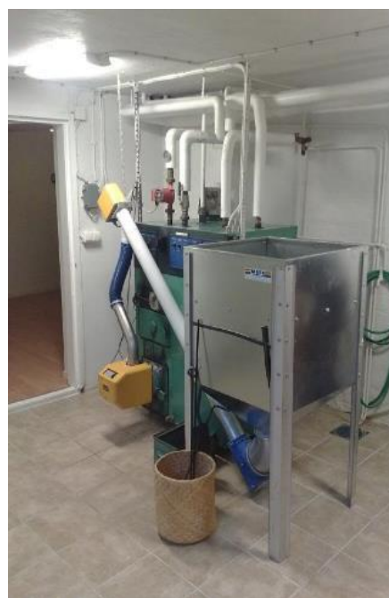
Bild 29. Alla värmepannor bör om möjligt installeras i ett avskilt pannrum.
