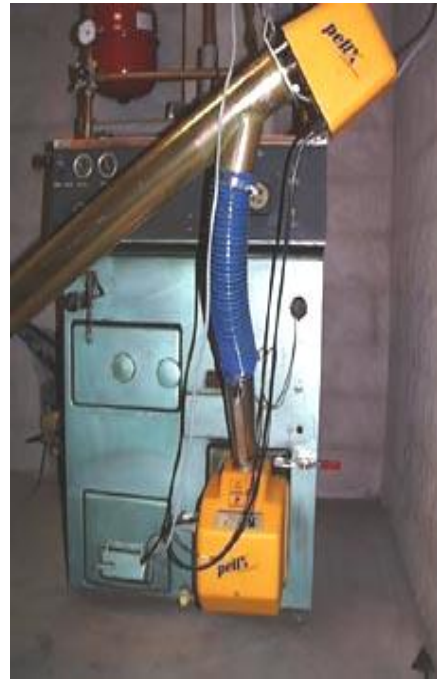
Bild 103. Den verkningsgrad som man mäter med en rökgasanalys hemma hos kunden är att betrakta som förbränningsverkningsgrad
