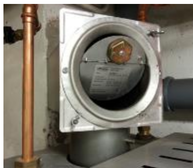
Bild 28. Motdragslucka monterad på förbindelsekanalen panna/skorsten
