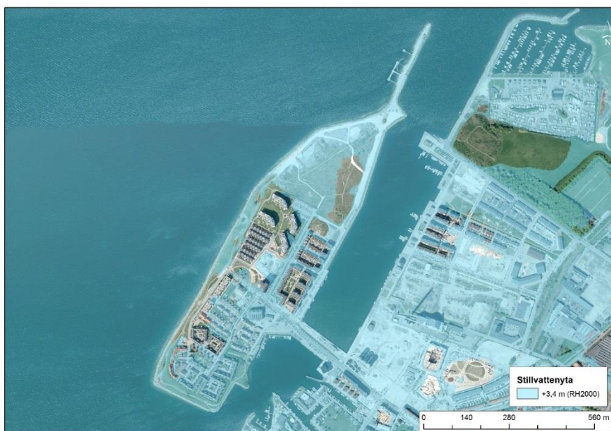
Figur 8.8 Översvämning vid ett extremhögvattnen år 2100. Ön isolerad, evakuering lämpligt innan högvattnet slår till. Glasbrukskajen helt översvämmad, vattendjup ca 0,1-0,5 m. Lagunen är helt översvämmad, vattendjup ca 1-1,5 m.
