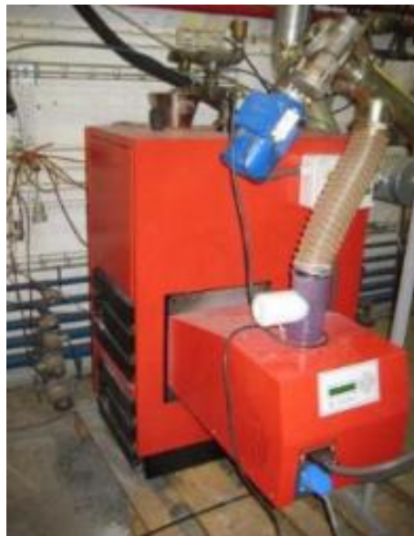
Bild 34. Teknik för eldning med spannmål och agro pellets är vanligare i länder som Tjeckien. Bilden är en Multibio 15 kW från Petrojet Trade s.r.o.
