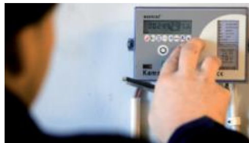
Bild 111. Varje abonnent har som regel sin egen mätare för att få rätt debitering av värmen.
