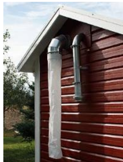
Bild 21. Exempel på avluftning med dammfilter t.v. Inblåsningsrör med handkoppling t.h.
