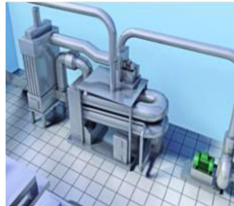
Bild 122. Rökgaskondensering är ett alternativ som även ökar verkningsgraden.
