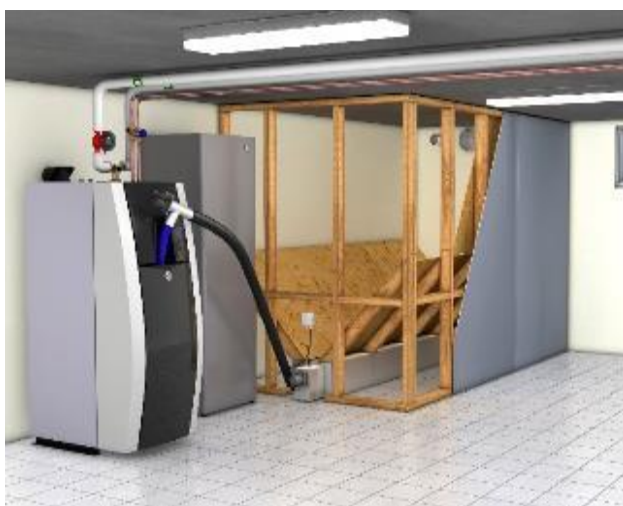
Bild 18. Det går utmärkt att platsbygga ett pelletsförråd men är du som installatör är osäker hur du skall göra bör du låta en byggfackman ge dig råd angående materialval och dimensionering av reglar, skivor mm.
