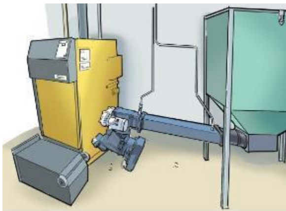
Bild 33. Exempel på modern fliseldning från Länsförsäkrings "BRASA"
