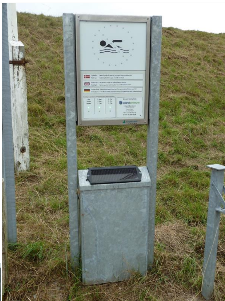
Elektronisk skylt som mottar energi från solceller – vid avrådan från bad tänds lampor runt simmande person – bottenlampor tänds när vattenkvaliteten är försämrad – skylten kan styras manuellt från det kommunala kontoret eller via ett automatiskt varningssystem som Badvattenutsikten (kapitel 8.3.4) Vänster: Närbild av skylt
